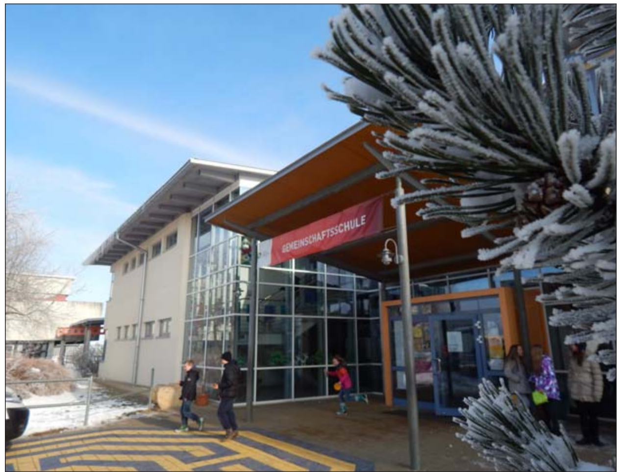
Die Gemeinschaftsschule Aldingen – hier der neuere Gebäudeteil – hat einen guten Ruf und ist auch bei Schülern aus dem Umland heiß begehrt. Damit alle Schüler weiterhin gut unterrichtet werden können, soll ein weiteres Gebäude entstehen. Fotos: Eric Zerm
