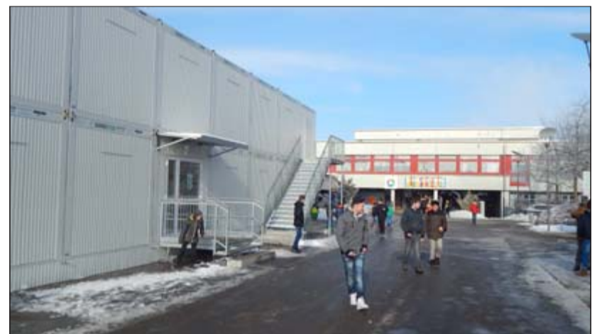
Die Gemeinschaftsschule Aldingen braucht mehr Platz. Aus den Containern (links), die auf dem Gelände stehen, soll keine Dauerlösung werden. Im Hintergrund: der älteste Gebäudeteil der Schule.
